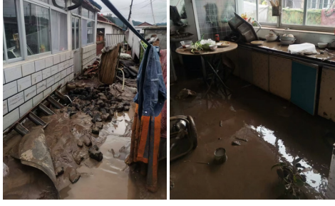
图为河北承德市滦平县金沟屯镇荒地村一村民家中受灾情况。(受访者提供)
