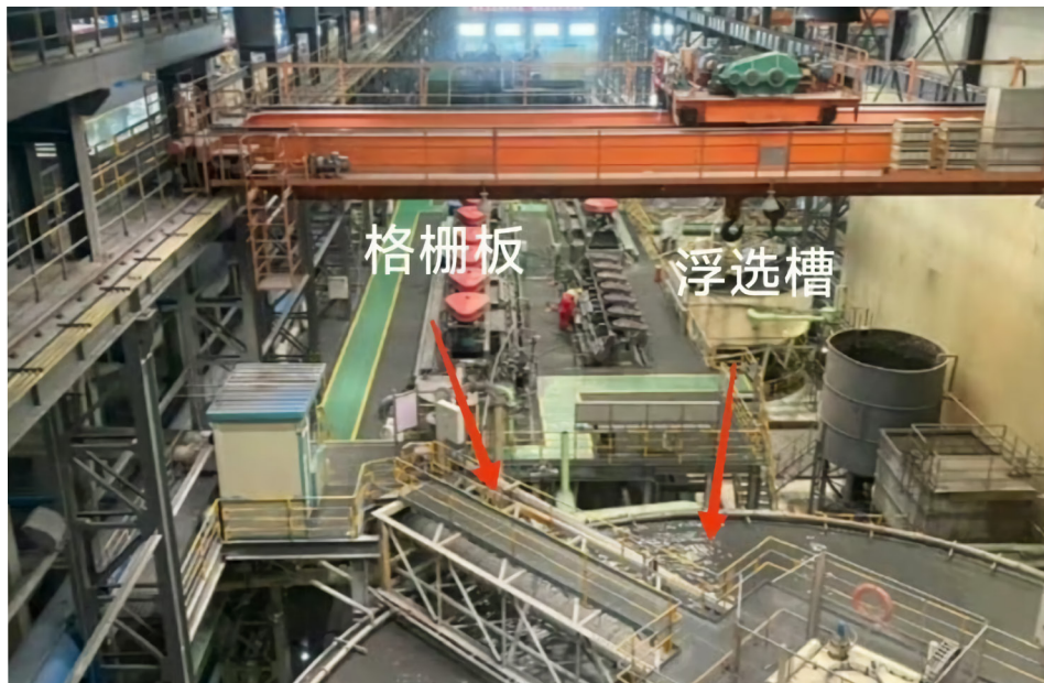
2025年7月23日，东北大学6名学生在中国黄金集团内蒙古矿业有限公司乌努格吐山铜钼矿选矿厂参观学习期间，因格栅板脱落坠入浮选槽身亡。
